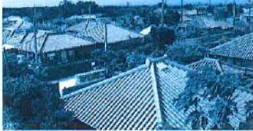
竹富島のまちなみ (国選定重要伝統的建造物群保存地区)
