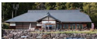
▲会津米沢街道 桧原歴史館 外観
