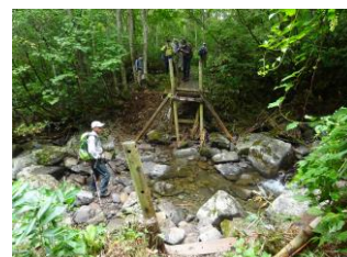
橋が流失しているので 通行注意
