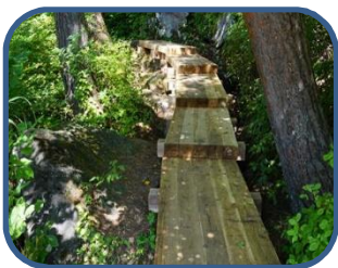
①木道改修工事の様子
