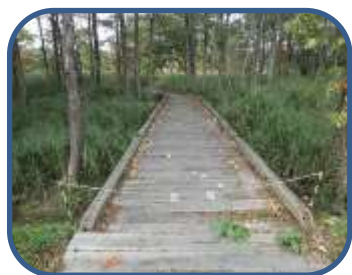
①木道破損箇所があります。
