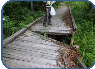
②破損した木道
